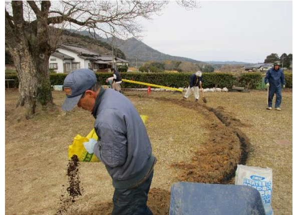
掘ったところに炭と堆肥を入れます
