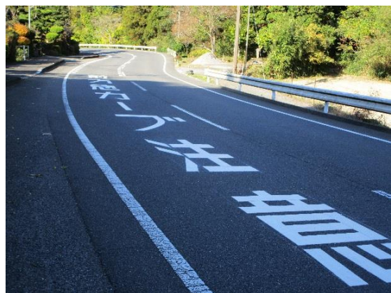
熊のつばめ石付近下り坂に注意喚起の標示
