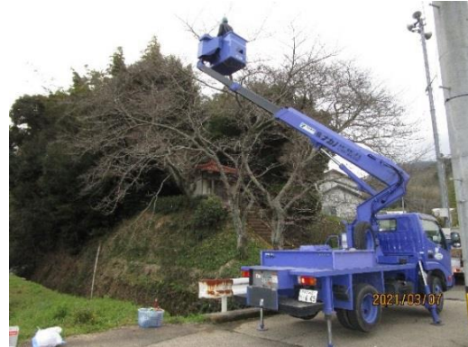
高い所は高所作業車で（観音堂）
