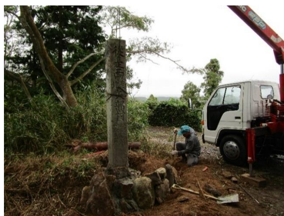
根を除き、据え直しました（施工は今戸造園さん）
