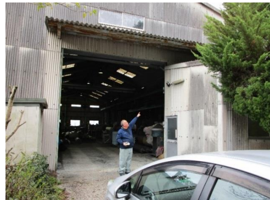
指差している箇所を設置(石井製作所宇佐工場)
