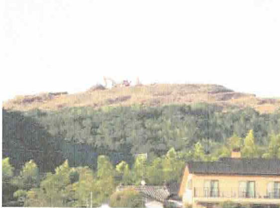
南西側（拝野尾方面）から見た工事現場
