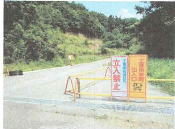
工事現場の入り口（トラックが離合できる幅の道路）
